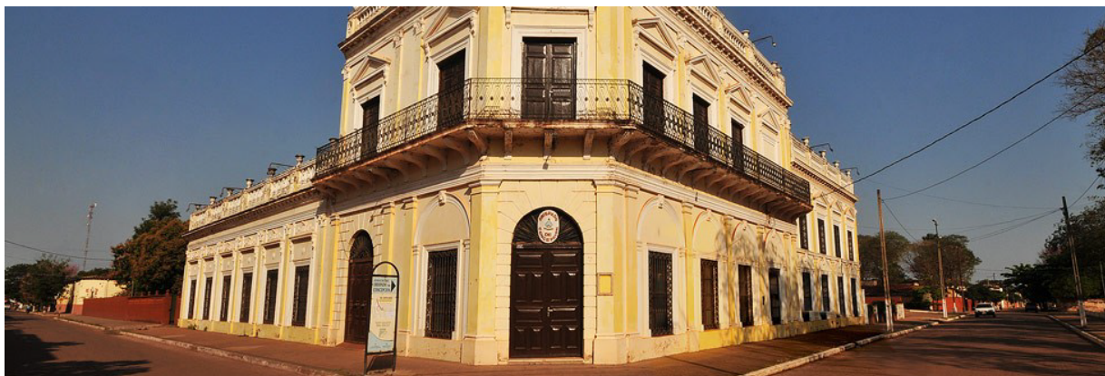
Fotografía 1: Línea Municipal de Esquina. Fuente: SIC-PY
