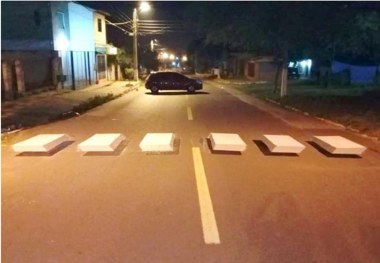
*Ilustración 5: Cruce peatonal 3D. Medidas para reducción de velocidad.*
