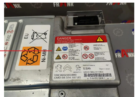
Fig. 47- Iconografía interna baterías NFPA-HEV-EV-Safety-Training-Student-Manual-1.0
